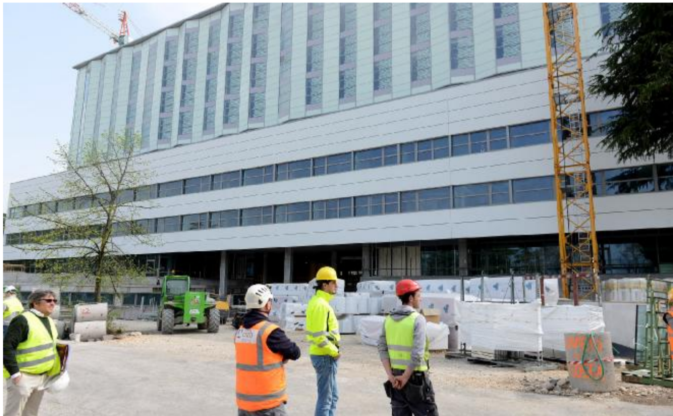
Il cantiere del nuovo blocco nord del Policlinico di Borgo Roma. Ospiterà il day hospital e gli ambulatori FOTOSERVIZIO DI GIORGIO MARCHIORI
