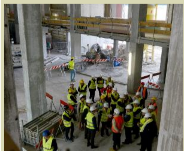
Il sopralluogo nel futuro ingresso del Policlinico
