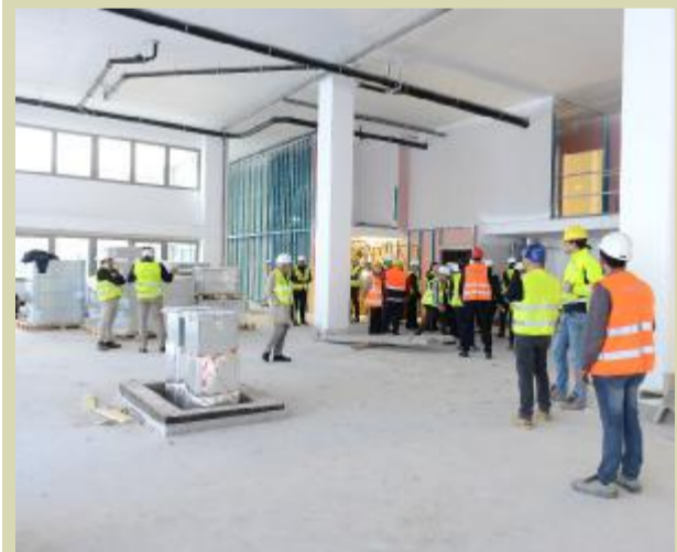
Il locale che ospiterà le attrezzature tecniche
